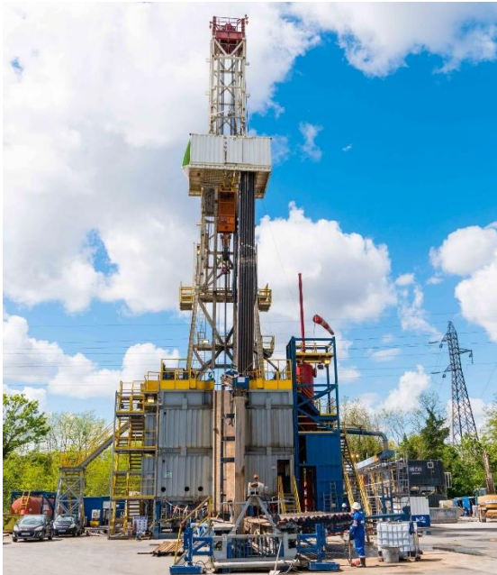
Travaux de forage géothermique
