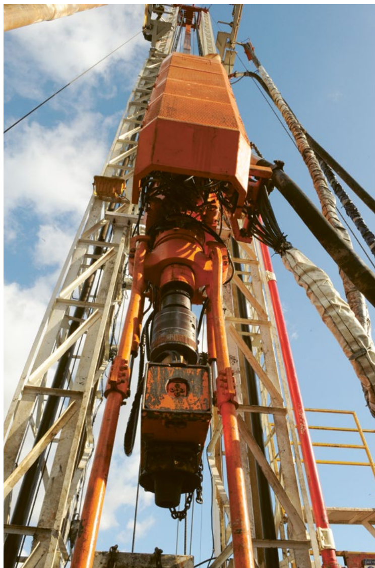
Machine de forage de géothermie.
