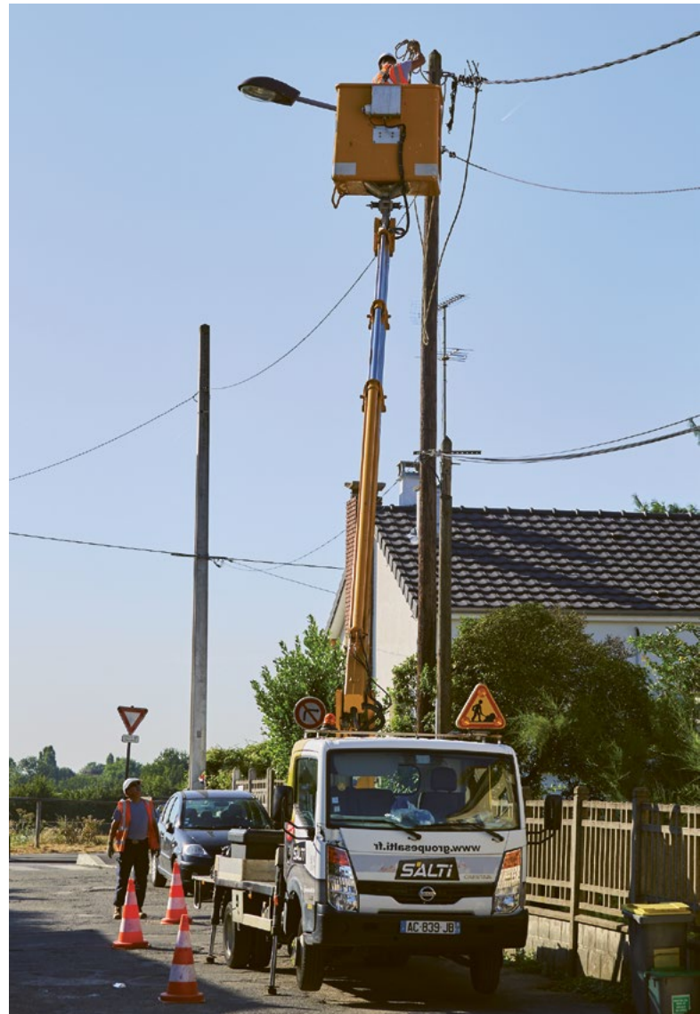
Intervention sur le réseau électrique aérien de Vitry.
