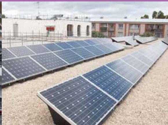
Médiathèque François Mitterrand à Clamart
